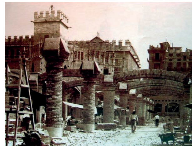
Obres del Mercat. Detall del soterrani.
